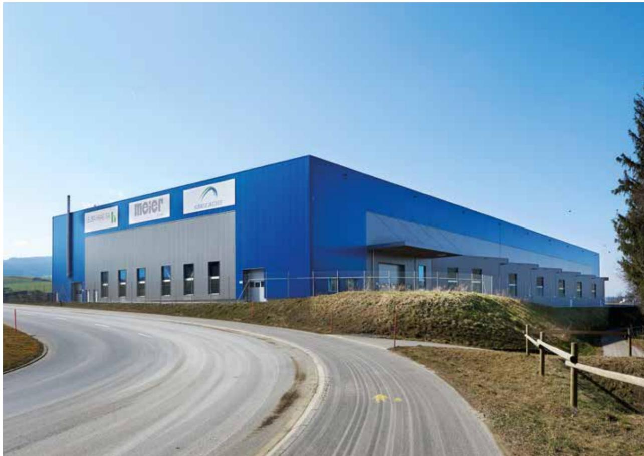
Der neue Standort der Kuratle Jaeger AG in Gibloux besteht aus einem 1'200 m<sup>2</sup> grossen Bürokomplex und einer Lagerhalle mit ca. 8'750 m<sup>2</sup> Grundfläche und einer lichten Hallenhöhe von 9.20 m. Die Hallenkonstruktion und das Büro sind in Holzbauweise erstellt und ruhen auf einem 80 cm hohen Betonsockel bzw. das Büro auf einer Betondecke über den Parkplätzen im EG.
