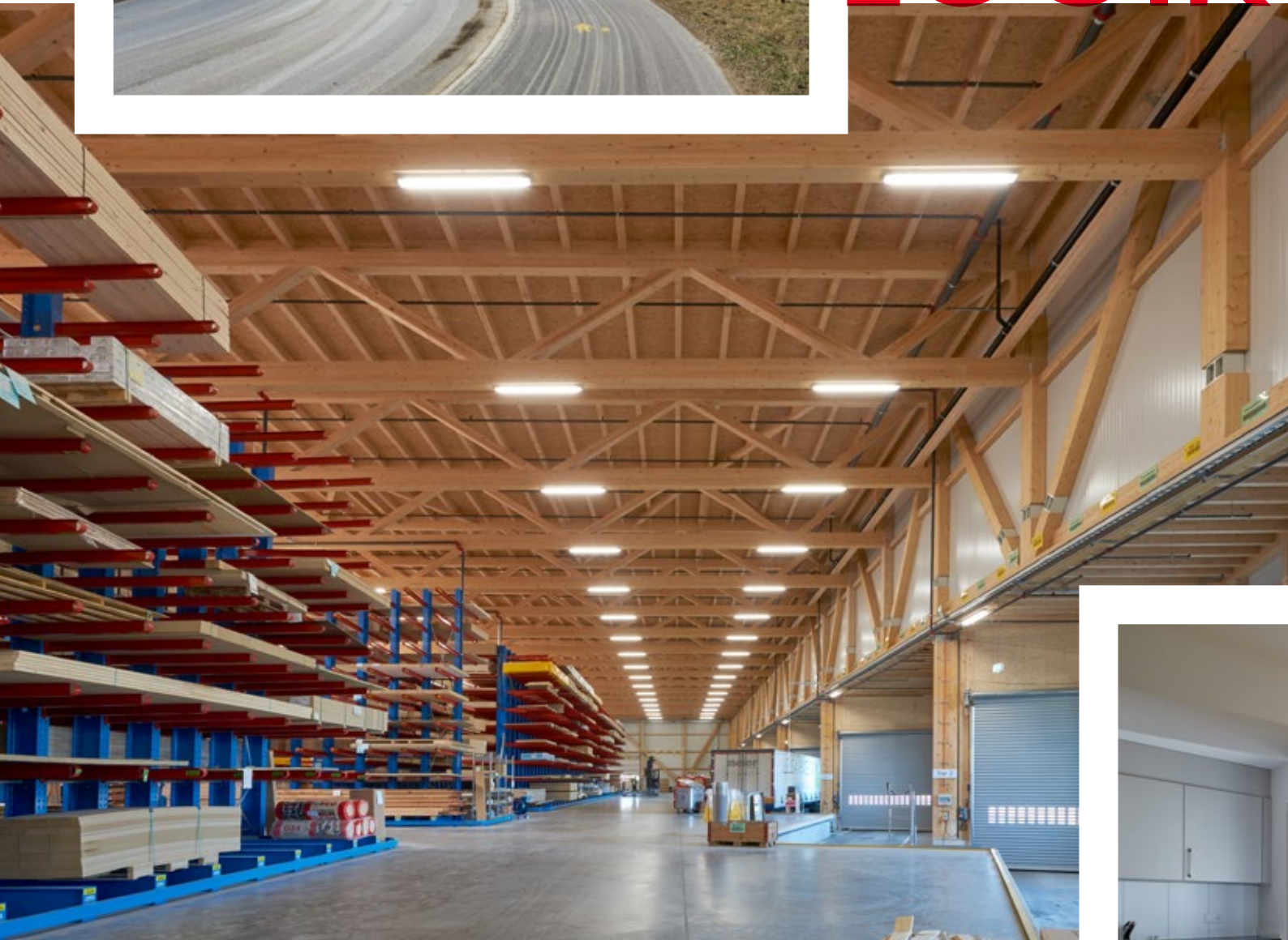
Logistikhalle mit Büro, Farvagny-le-Petit
